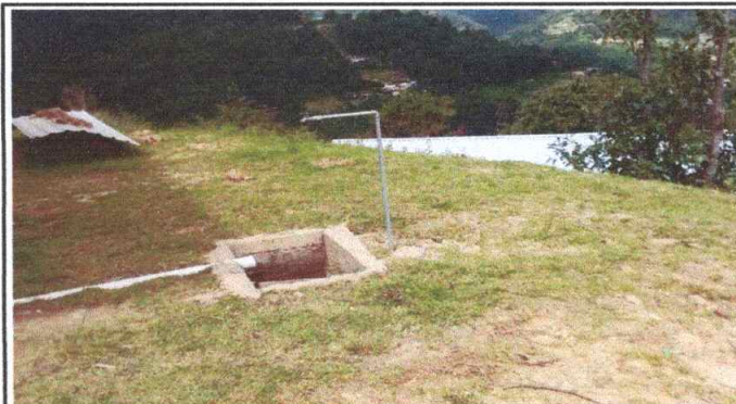
Foto 8: Sustrucción de pila de cemento de un lavadero
