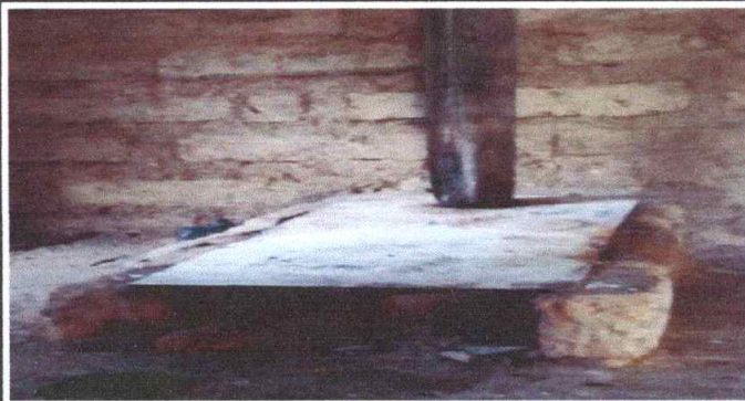
Foto 2: Sustrucción de lamina por lamina trokleada marca Aluzinc calibre 26
